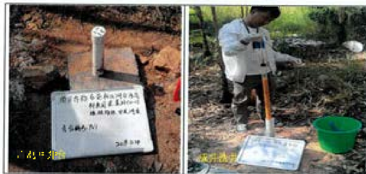
图 4.2-3 地下水监测井成井过程
