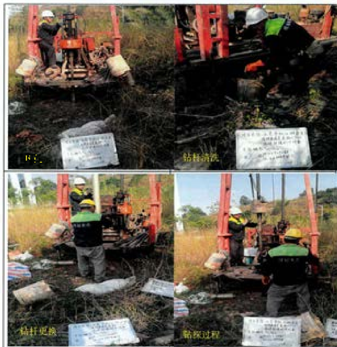
图 4.2-1 土壤钻探过程现场照片
